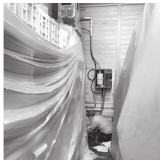
改修中の空調機器類
