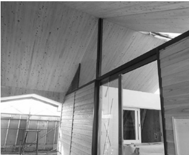
▲工事が進む勝間田駅(駅舎内部)
