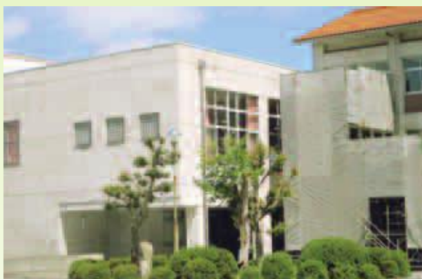
改修中の中学校
