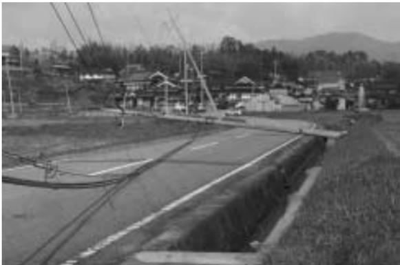
強風で倒れた電柱(下町川)
