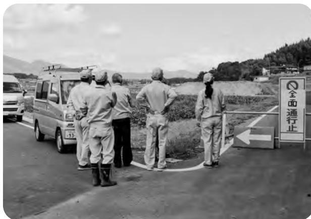
▲町道美野北線・大柳線の改良工事現地視察
