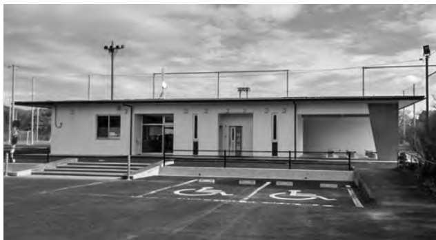
▲一般利用が望まれている勝央緑地運動公園の管理棟
