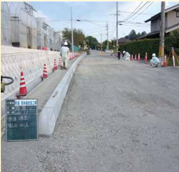
拡幅工事の進む勝間田保育園前道路
