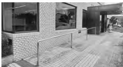
▲正面玄関のスロープ
