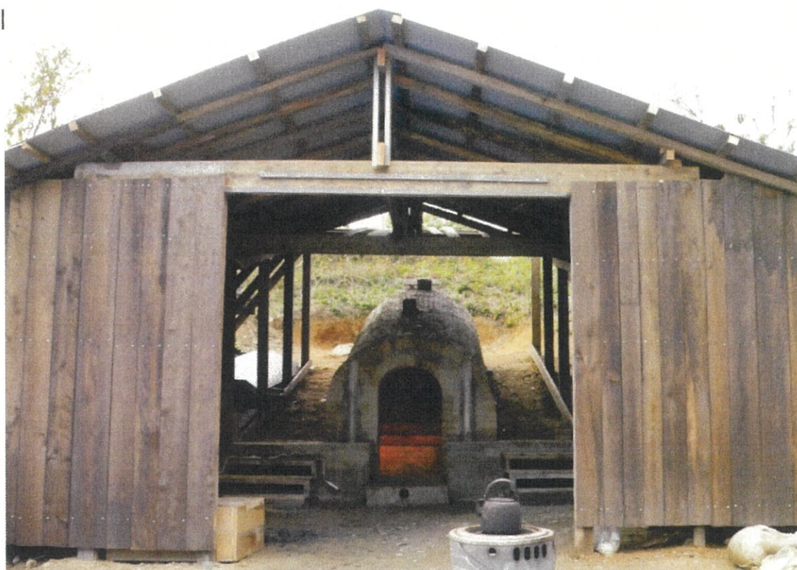
完成した建屋
