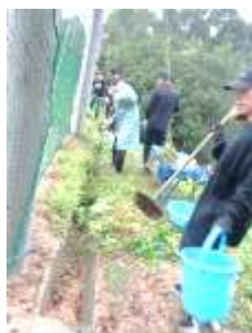
側溝の溝さらえ
